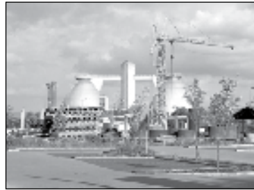
„High-Tec“: Kassels Kläranlage
