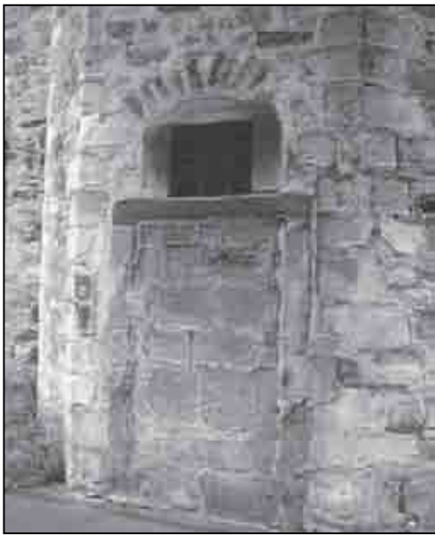
Die 1862 zugemauerte Türe im Treppenturm
