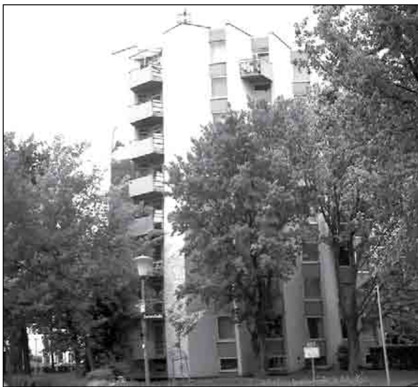
Das Wohnheim an der Weserstraße bietet Platz für 71 Studierende.
