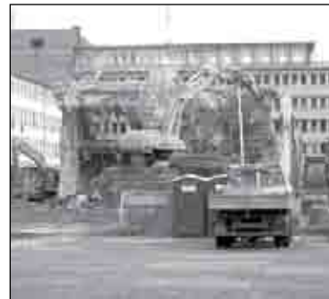
Der Beginn des Abrisses des Polizeidienstgebäudes.
