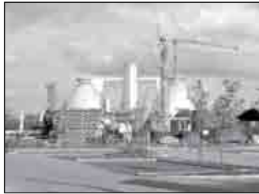
„High-Tec“: Kassels Kläranlage
