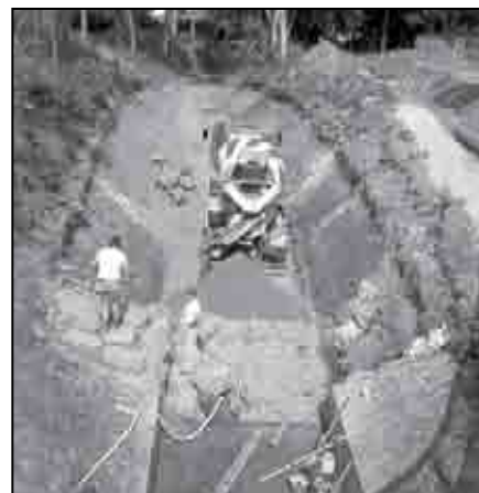
Renaturierung der Ahna: Sie wurde teilweise so weit verbreitert, dass sogar ein Betonmischer hineinfahren konnte.
