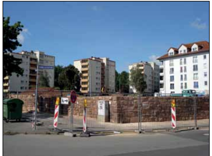
Links der historische Reitstall vor dem Abriss. Rechts das Reitstallgelände nach Abriss des historischen Gebäudekomplexes.
