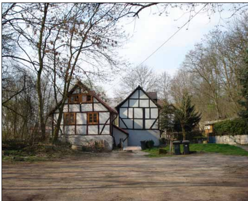
Der Schotterparkplatz vor den Lohgerberhäusern soll zu einem hübschen kleinen Platz umgestaltet werden.
