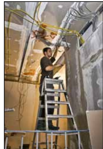
Ein Azubi bringt den Anschluss für die Deckenbeleuchtung an..
