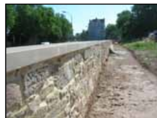
Entlang der bereits sanierten Stadtmauer wird zukünftig ein Weg verlaufen - abseits der befahrenen Schützenstraße.
