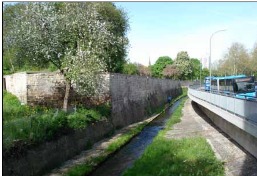
Die Ahna wird renaturiert und mit einer Brücke überquerbar gemacht.
