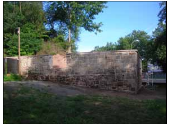
Durch diese Lücke in der Mauer wird eine direkte Wegeverbindung zwischen Finkenherd und Bleichwiesen gebaut.
