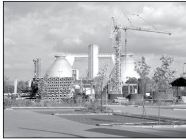
„High-Tec“: Kassels Kläranlage
